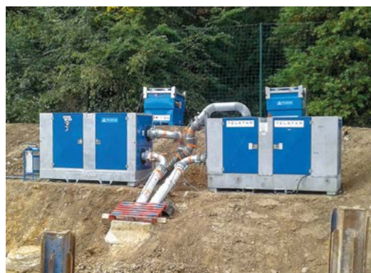
Betsy - Détournement d'égout.
