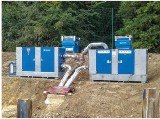
Betsy - Détournement d'égout.
