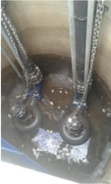
La mise en place des Subo ...
