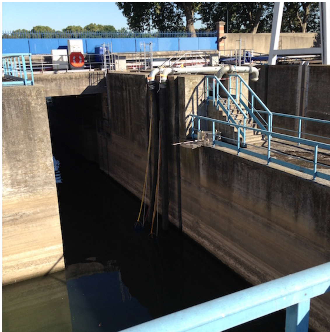
Les 2,10 F K sont installées...
