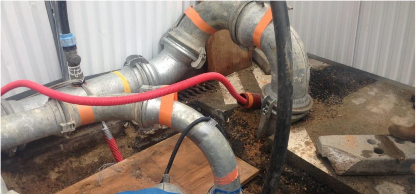
... qui reprend les rejets de L' Hidrostal immergée dans le collecteur d'eaux pluviales
