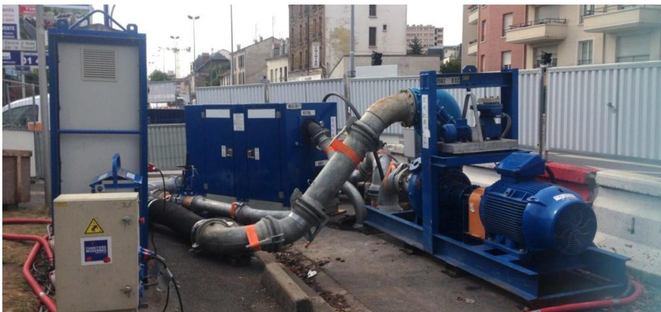
La première station avec les 2 Hidrostał et les armoires
