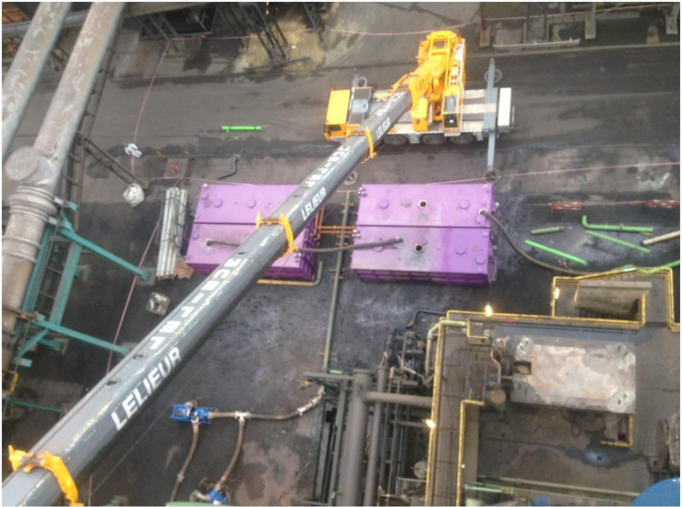
Le by-pass avec les deux Varisco et les réservoirs tampons
